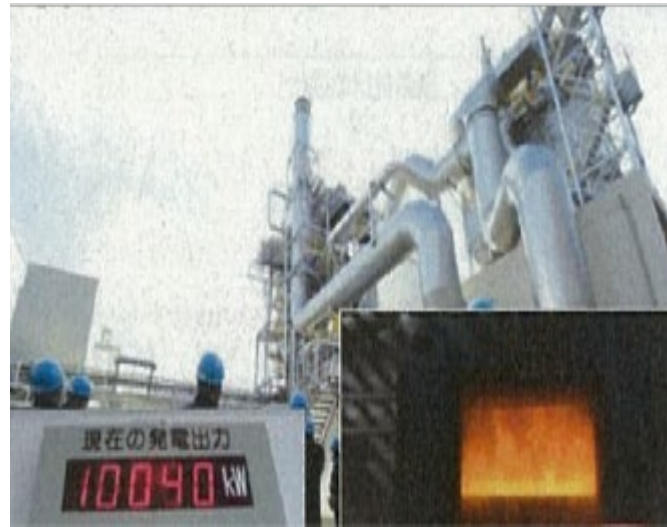
稼働中の木質バイオマス発電施設
