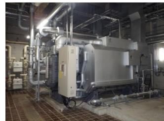
高効率ガス吸収式冷温水機
