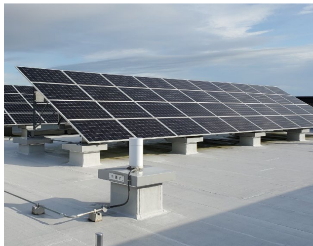
太陽光パネルの設置
