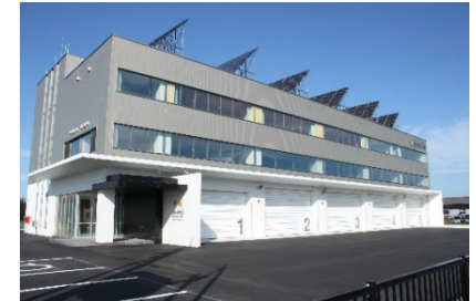
導入施設: 白糠消防庁舎
