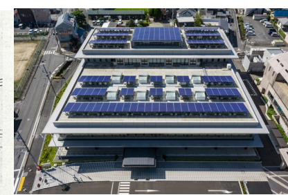
太陽光発電 (159kWh)
