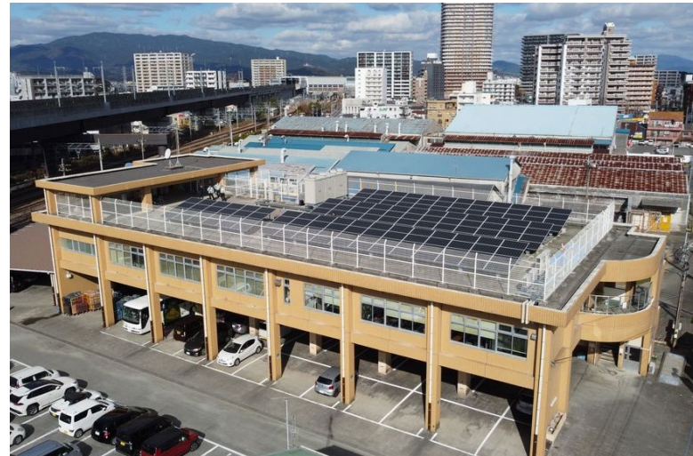
環境部庁舎全景
